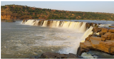
Projet Hydro-électrique de Gouina
