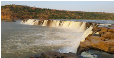
Projet Hydro-électrique de Gouina
