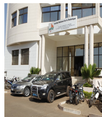
Façade "Entrée" de l'Institut National de la Statistique
