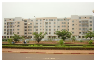
Imm. du MEF à l'ACI 2000 abritant l'INSTAT
